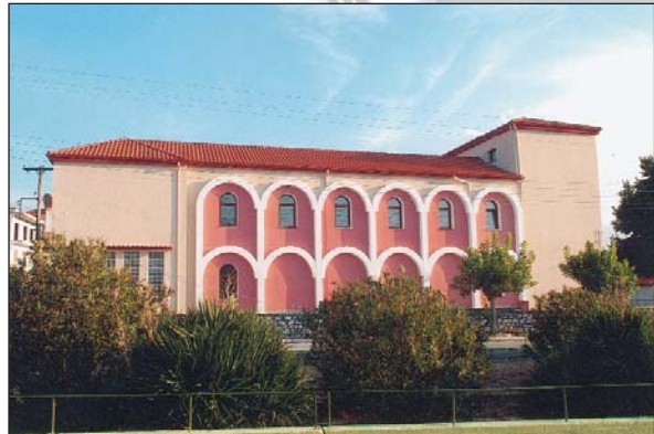
Το νεοανακαινισμένο Πνευματικό Κέντρο της Γ. Μ. Σιδηροκάστρου (Δεκέμβριος 2006).
